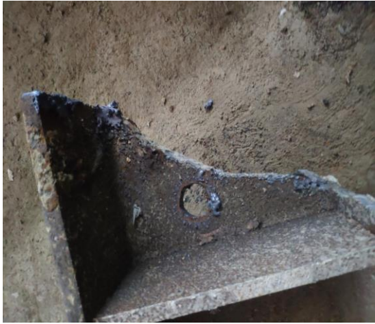
钢立柱顶部先切割一个斜口
