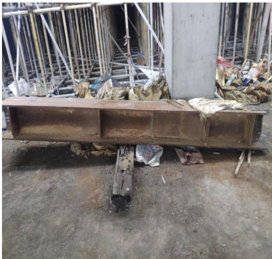
钢立柱下方垫枕木
